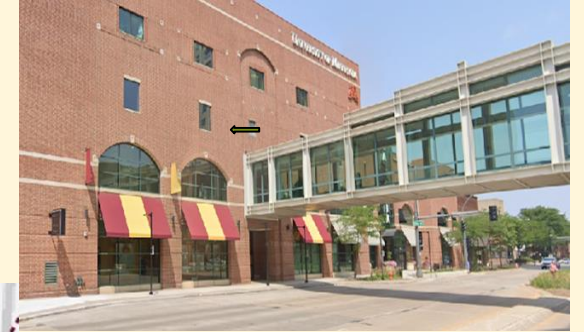
5. New windows on Broadway Ave S.
